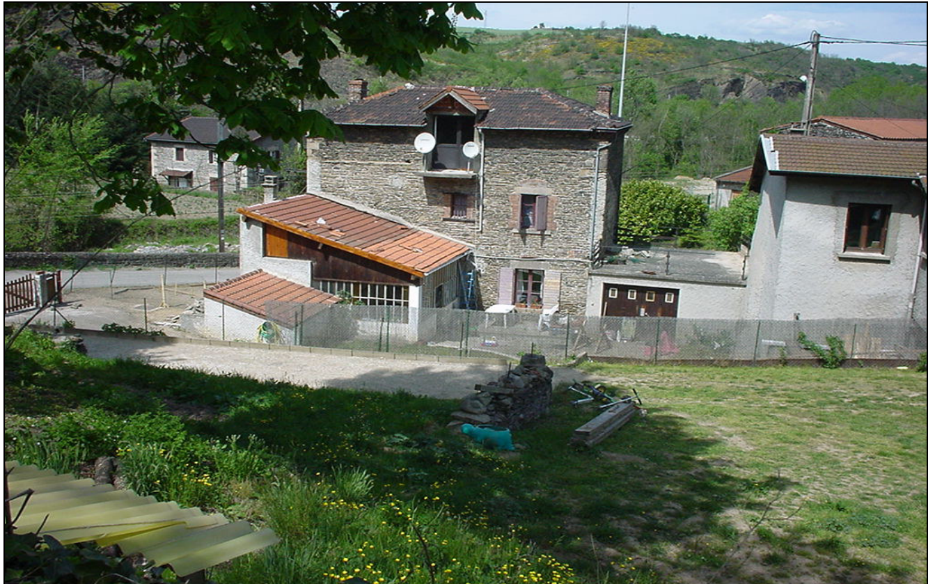
Les eaux de ruissellement traversent la parcelle du propriétaire B (habitation à droite) et rejoignent la parcelle du propriétaire C (habitation à gauche).
