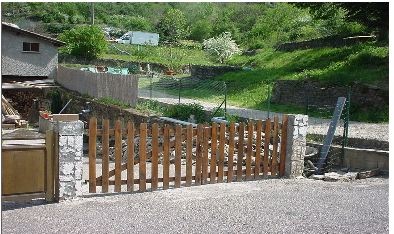
Les eaux de ruissellement passent par dessus le muret et arrivent dans la cour intérieure de la parcelle du propriétaire C.
